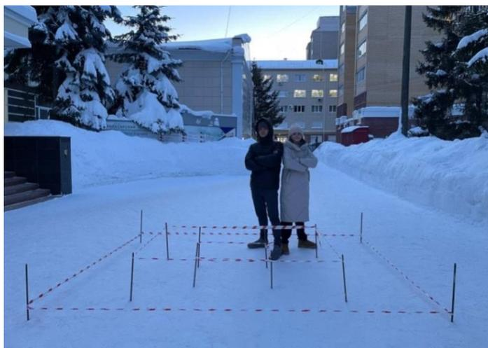
Рис. 2 – Разметка границ фундамента стаканного типа
