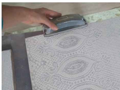
Рис.2 Шлифовка рельефной поверхности
